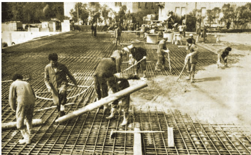
Prikaz ugradnje betona
